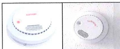
Figura 14: Detector de humo del Laboratorio de Biología
